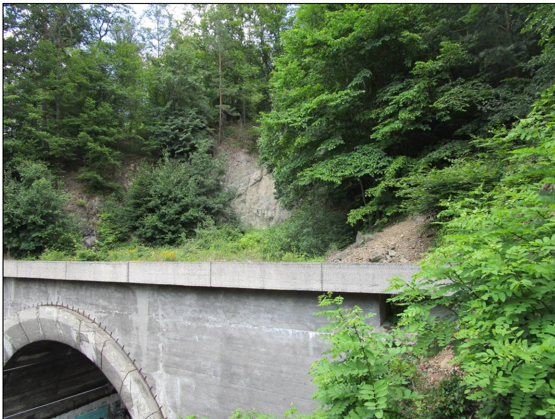
Obr. č. 21 – celkový pohled na skalní stěnu za vjezdovým portálem, vpravo osyp zvětralin a silně zvětralých granodioritů z pravé boční stěny
