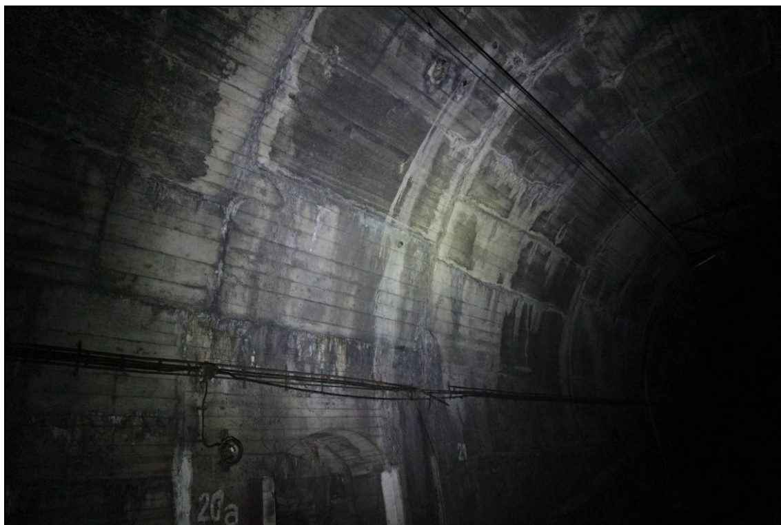
Obr. č. 33 – pohled do na klenbu tunelového pásu č. 20a a 21 - vlevo nad kolejí č. 1 - středně silné dlouhodobé skrze trhliny v ostění a v pracovních a dilatačních spárách
