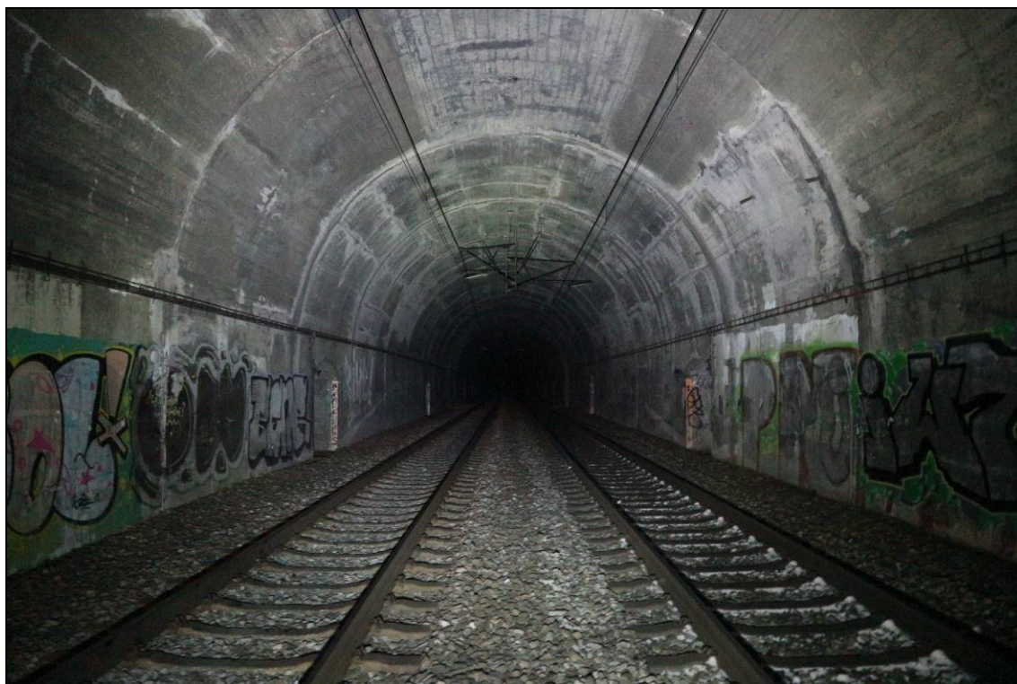
Obr. č. 29 – pohled do tunelu od vjezdového portálu P/1 - patrné dlouhodobé průsaky skrze pracovní a dilatační spáry
