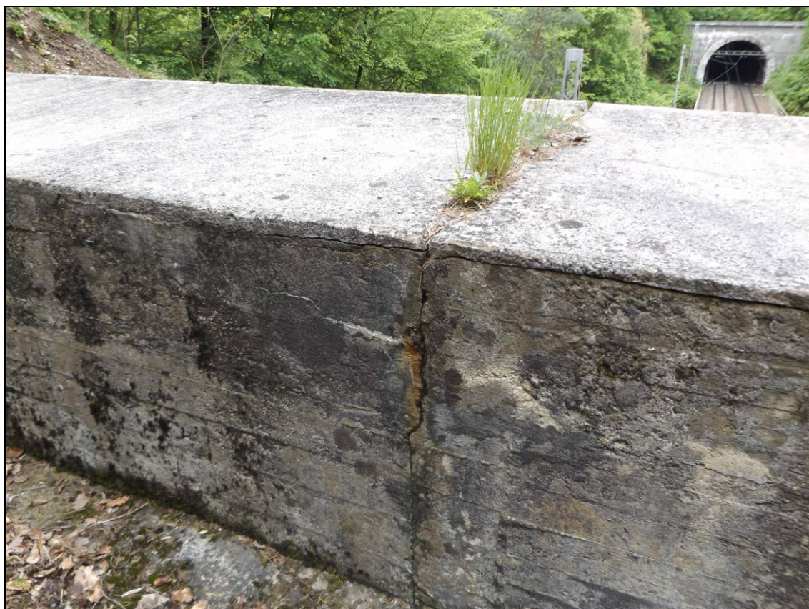
Obr. č. 27 – pohled na dilatační spáru závěrné zdi s průsaky a vegetací
