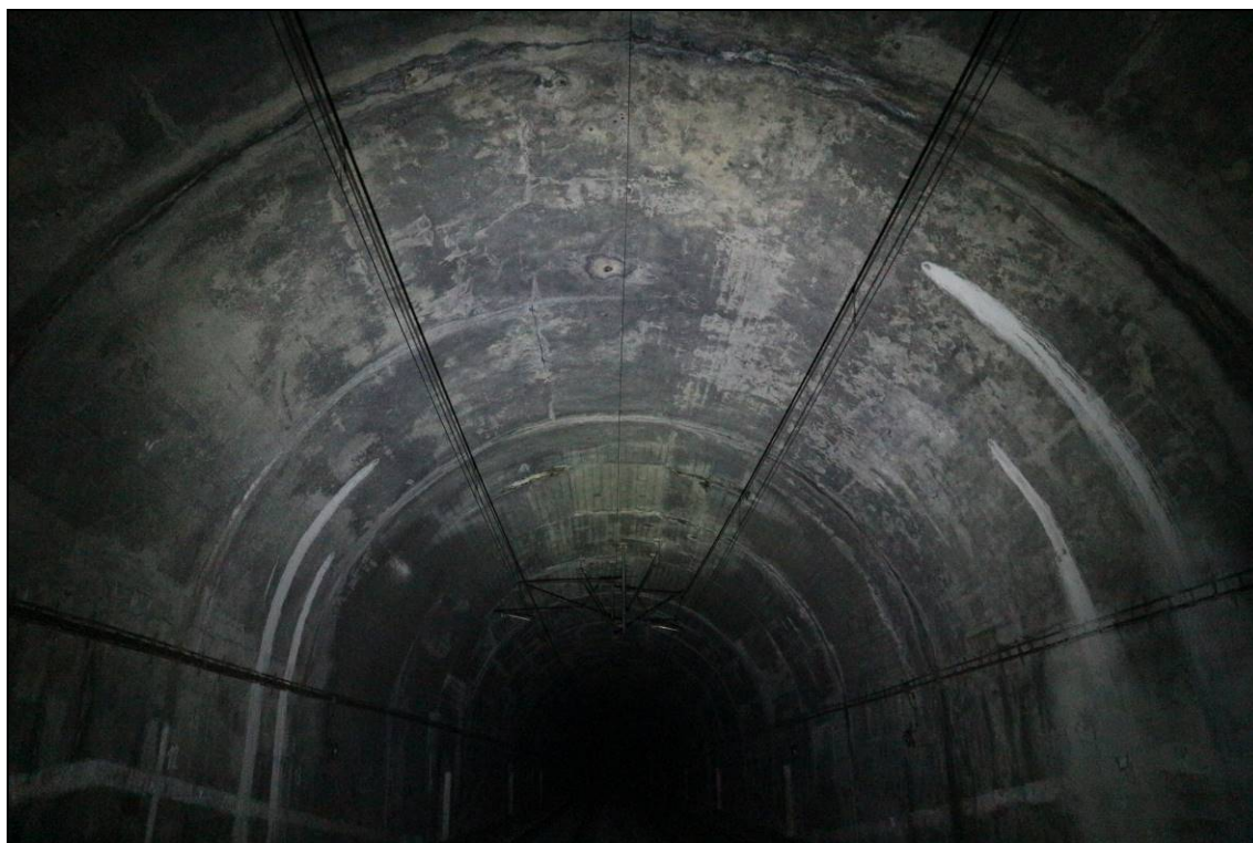
Obr. č. 31 – pohled do na klenbu tunelového pásu č. 11 a 12 - místo závalu z roku v 1968 - plošné dlouhodobé průsaky skrze stříkaný beton klenby, pracovní a dilatační spáry
