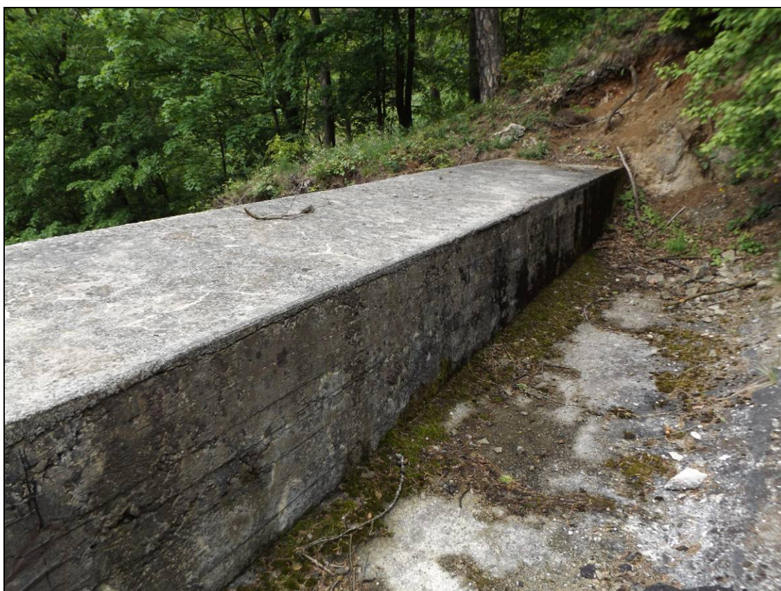
Obr. č. 26 – pohled na zadní stranu závěrné zdi portálu a odvodňovací žlab za ní
