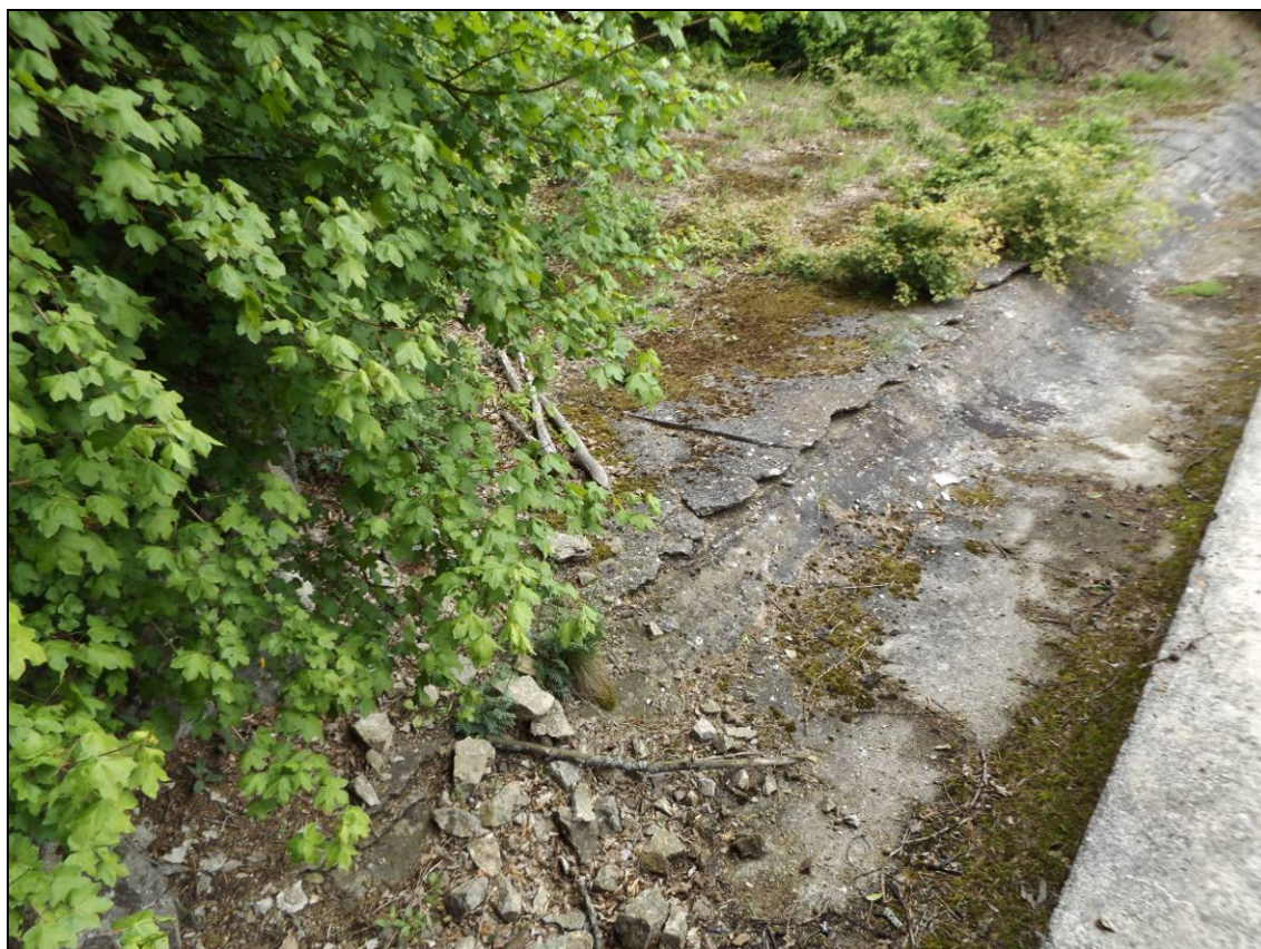
Obr. č. 25 – pohled na porušené a odtržené okraje prefabrikovaných desek
