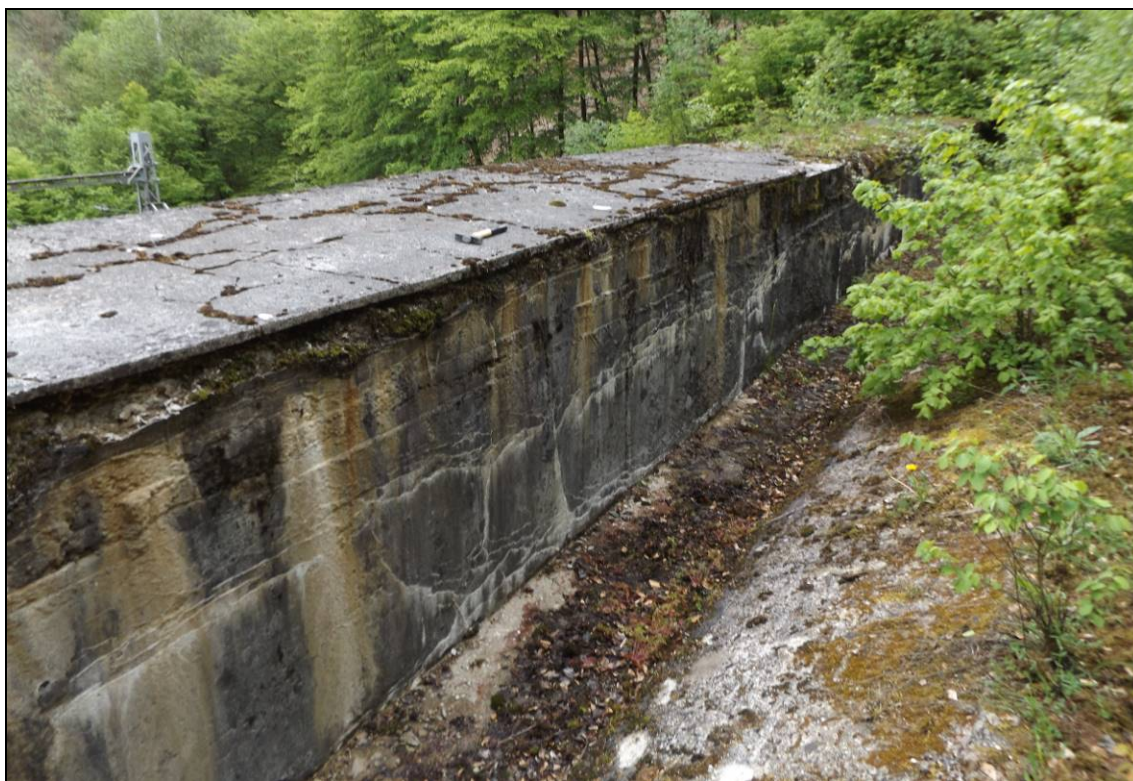
Obr. č. 36 – pohled na závěrnou zeď ze zadní strany – porušený líc zdi s trhlinami a usazeninami – porušená deska s pemrlovanou omítkou celoplošně odtržena od podkladu – odvodňovací žlab vedoucí podél závěrné zdi
