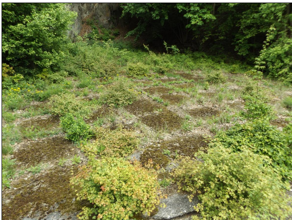
Obr. č. 24 – pohled na plochu nad portálem tvořenou prefabrikovanými deskami, porostlými náletovou vegetací
